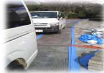
ILB工事汚れ抑制養生。カニクレーンのキャタ下養生。
